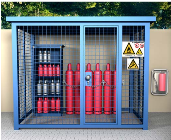
Abb. 32 Lagerung von Flüssiggasflaschen im Freien
